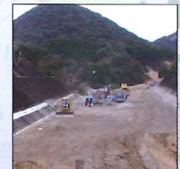
高速道路をつくるために土を盛る工事
