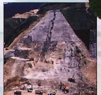
ダムをつくるために山をならす工事
