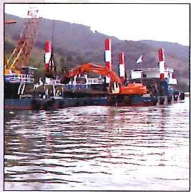
河川に流れる水量を増やすために川の底を掘り下げる工事
