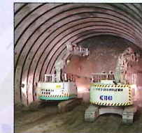
トンネルをつくるための穴を掘る工事
