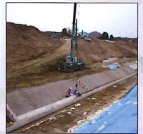
形が変わりやすい海や川の地盤を強くする工事
