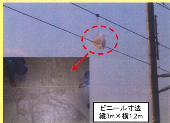
〔電線に引っかかった建設用ビニール〕
